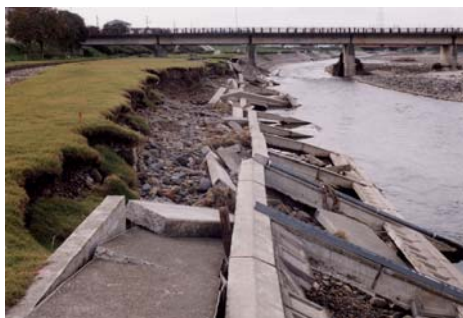
阿武隈川小峰あぶくま公園護岸の損壊 (1998年)
