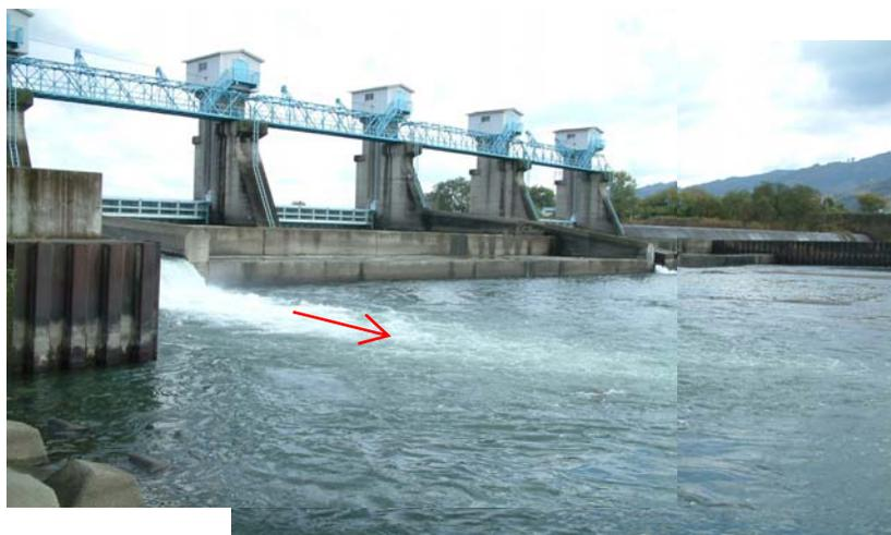
図-5 小田頭首工下流の河床低下状況（2006年撮影）
