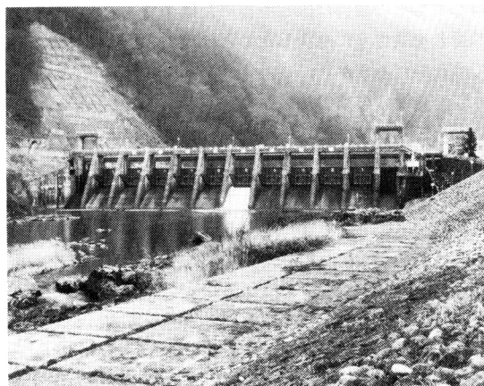
写真-1 庄川用水合口堰堤
