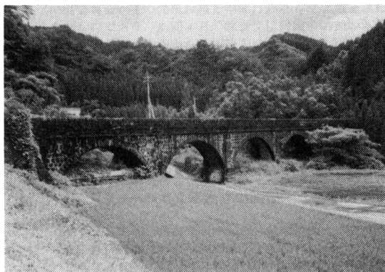
写真-1 洪石橋（六連の水路橋）
