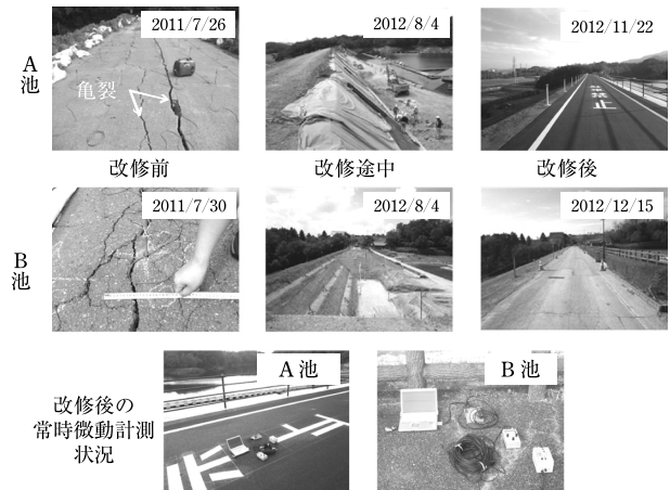
写真-4 計測施設の復旧状況
