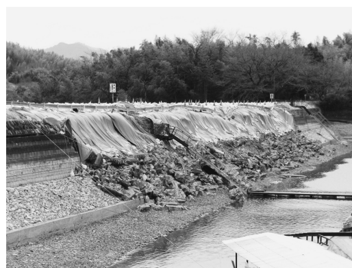
写真-3 A池上流部波返工の崩壊状況（東日本大震災後）
