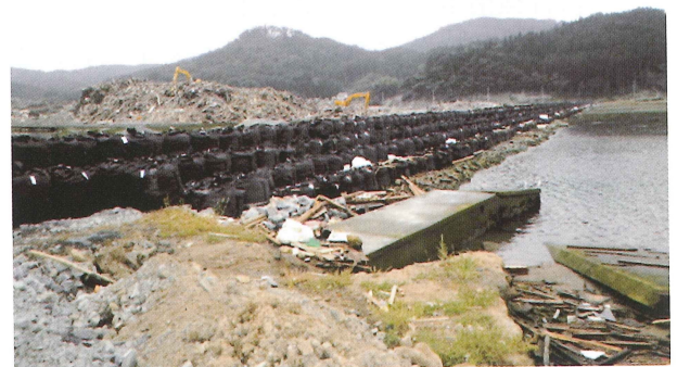
写真-4 全壊した海岸堤防の応急仮締切 (陸前高田市小友地区)
