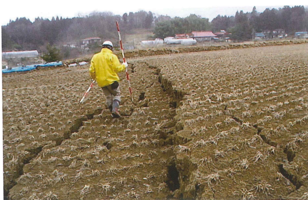
写真-5 地すべりにより亀裂が入った水田 (一関市須川地区)
