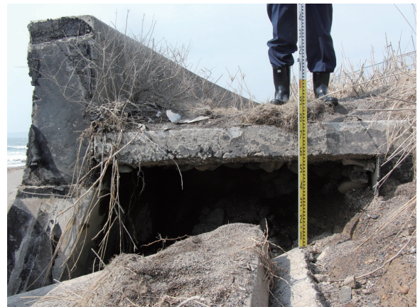
写真-2 松神地区海岸保全施設堤防の損壊 (90 m)
