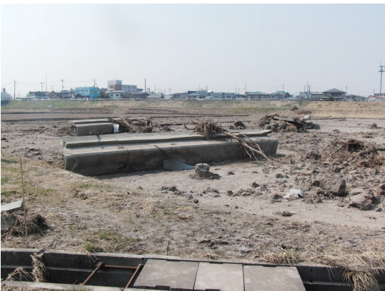
写真-5 奥入瀬川右岸水田の冠水被害（水路の流失）
