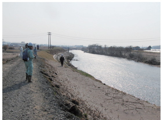
写真-6 (c) 五戸川の堤防を津波が越流した
