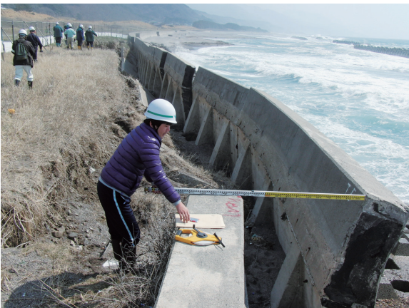
写真-2 松神地区海岸保全施設堤防の損壊 (90 m)
