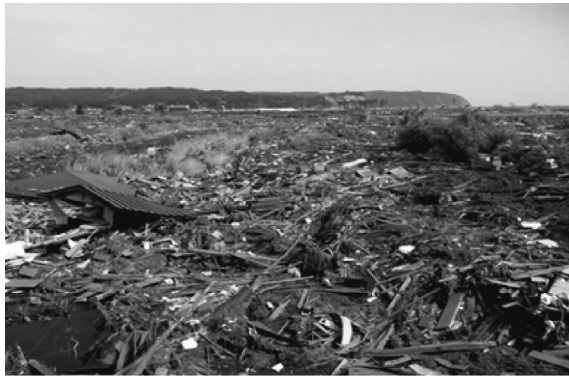
写真-1 野田村泉沢地区 被災状況
