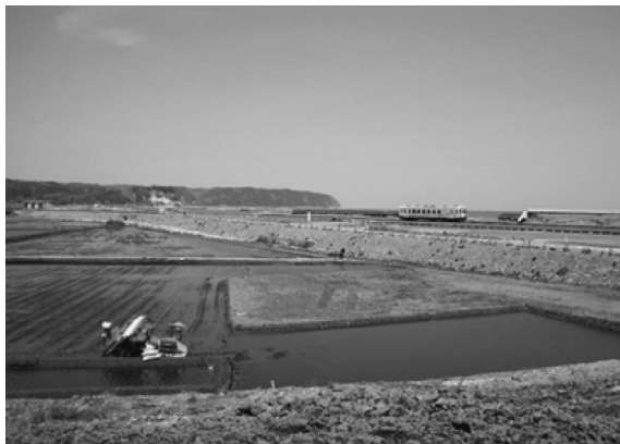
写真-2 野田村泉沢地区 復旧完了状況
