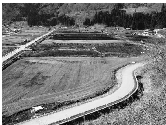
写真-3 宮古地区摂待工区 施工状況
