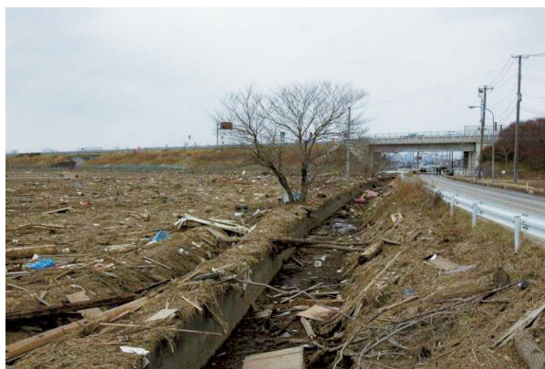
排水路（仙台市若林区二木前）津波による多くの流木等が見られる。水は引いている。奥に見えるのは仙台南部道路。
