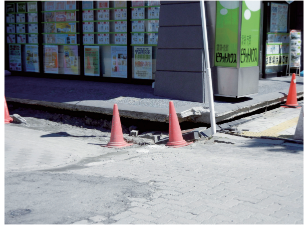
液状化で地盤が 30 cm ほど下がっていた（入船 4 丁目）
