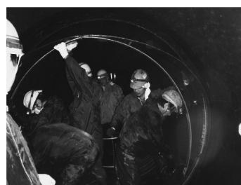
写真-9 内面からの応急復旧対応
