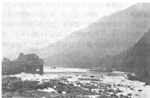
写真-3 白山堰堤
