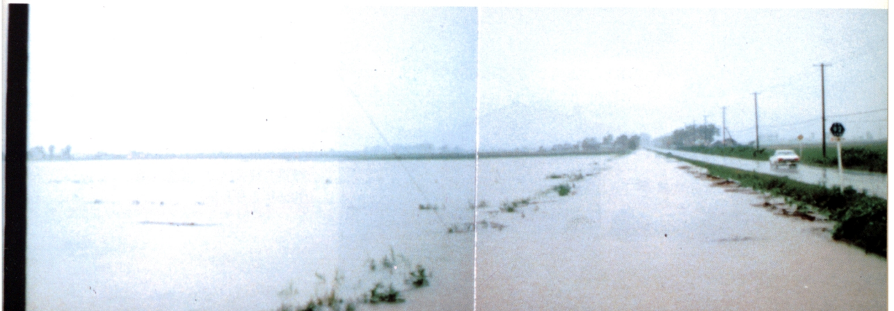
旧美唄川流域千間道路付近の被害状況（撮影：昭和56年8月4日）
