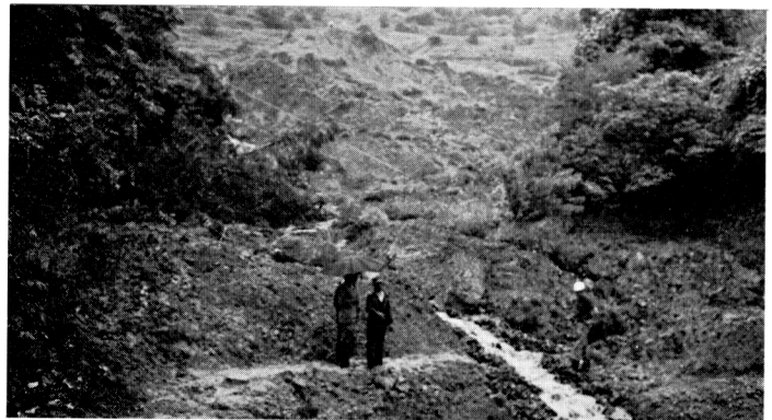
島根県簸川郡佐田町反田地スベリ対策事業予定地。 豪雨により農地がすべり出した。 手前は流亡した状況
