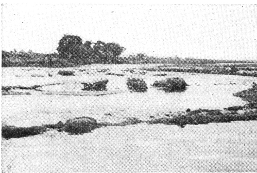
写真 1 惠利堰被害状況
