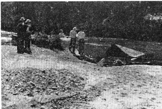
写真 4 万年堰被害状況(右岸袖の残骸)
