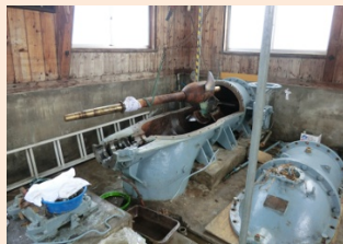
＜ポンプのオーバーホール＞
