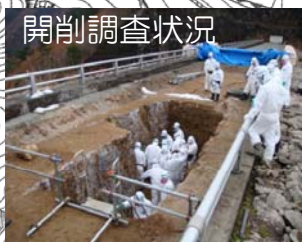
上流地覆付近の陥没
