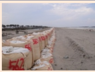
＜仮締切り堤防設置＞
