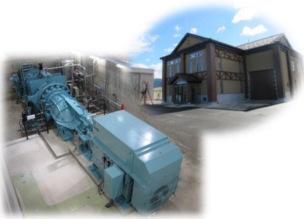
宮竹用水第二発電所
