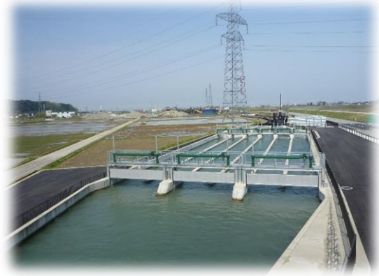
宮竹用水沈砂池
